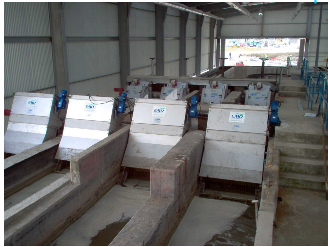
Dégrillage fin et grossier / Tamisage Coarse and fine screening / Sieving
